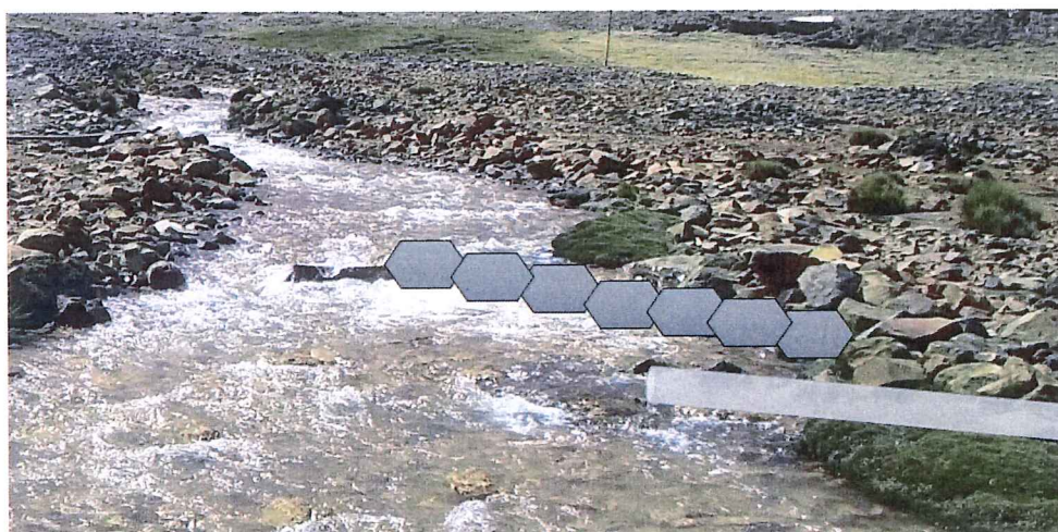
Figura 5 Colocación de dique de rocas para evitar excedentes durante la época húmeda
